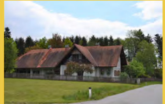
Licht- und luftdurchlässige Einfriedung, Hitzendorf
