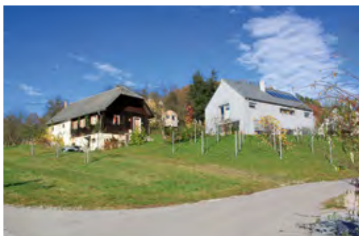
Neubau Äußere Ragnitz, Kainbach
