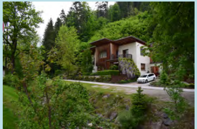
Pulldach bei Wohnhaus in Krenhof, Köflach
